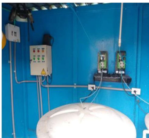
Instalación Tubería SCH 40 Y Tomas GFCI
