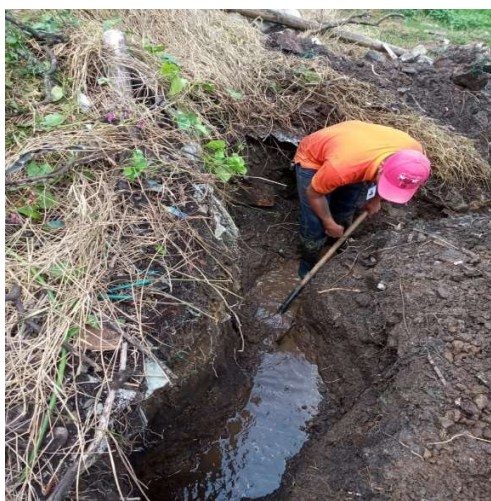
Inicio búsqueda fuga de agua parque Corregimiento Moctezuma
