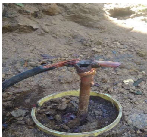
Soldadura Exotérmica
