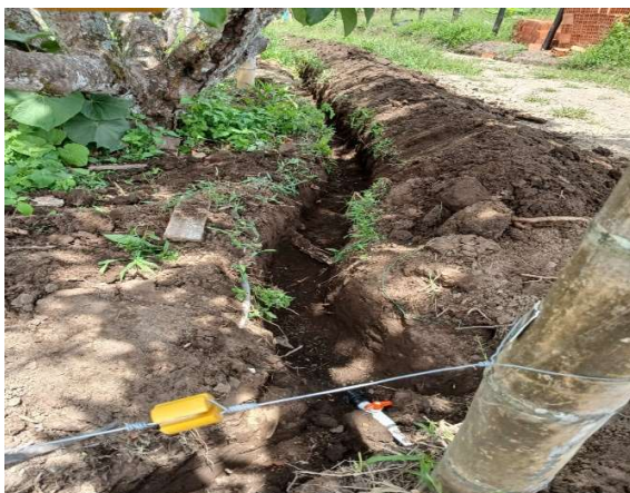
Excavación para ampliar red Finca La Miranda
