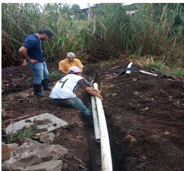
Traslado Tubería 3" PVC Vda. El Cofre
