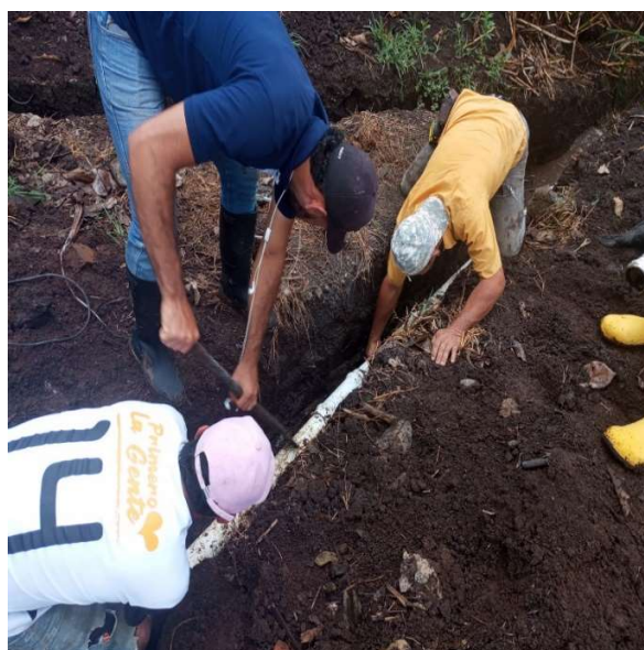
Corte y empalme tubería 3" PVC Vda. El Cofre
