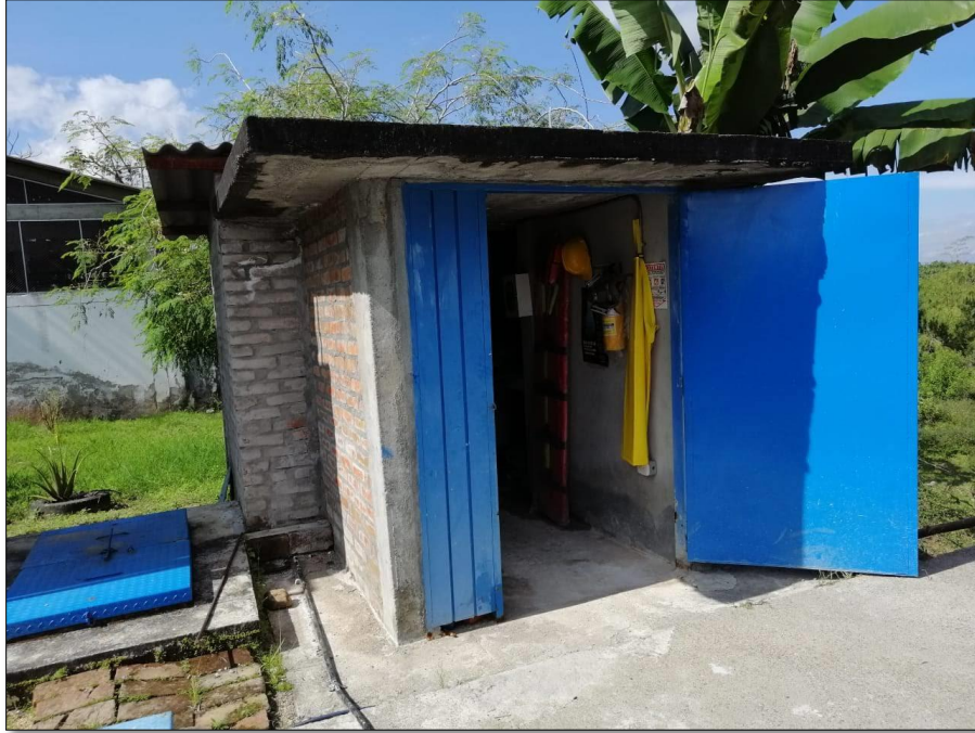
Imagen 18. Caseta De Dosificación
